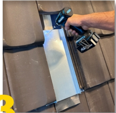
Blechziegel mittels Dichtschraube auf den Dachlatten befestigen
