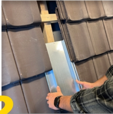
Blechziegel einsetzen
